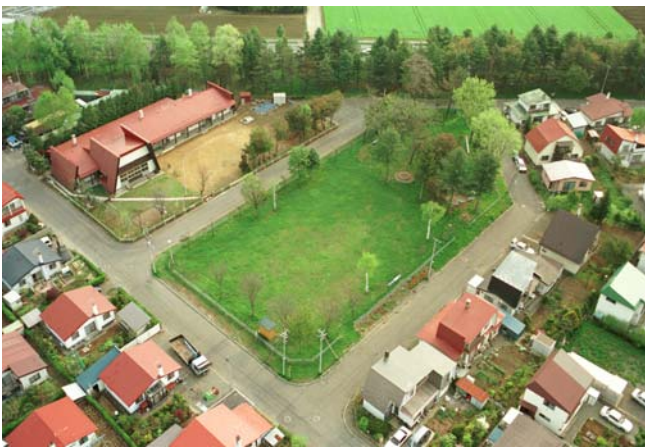
根室市産業廃棄物処理場竣工写真
